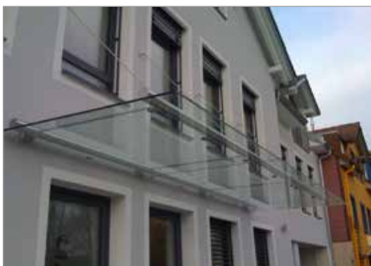
Breite Überdachung mit Gläsern auf Stoß
