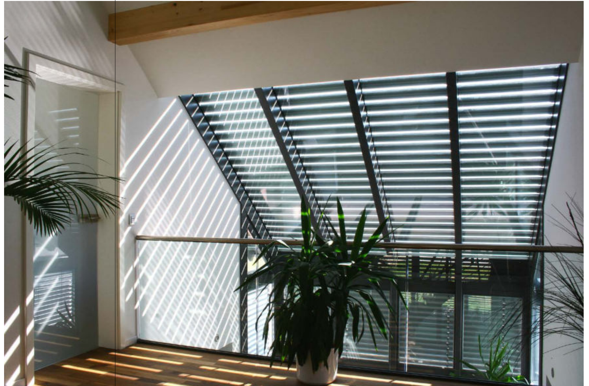
Mit schönem Lichteffekt: Die energieeffiziente Beschattung über zwei Etagen.
